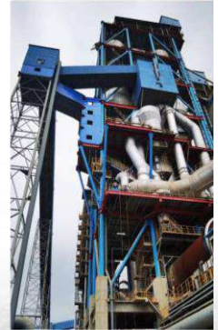
Hệ thống buồng đốt trước của nhiên liệu thay thế
