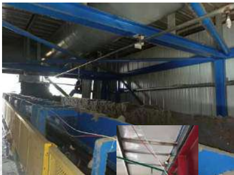
Đường ống và búp phun nước cho băng tải
