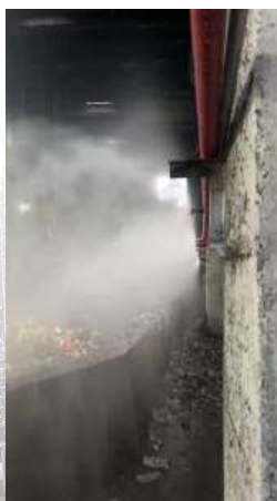
Đường ống và búp phun nước cho kho chứa rác thải dễ cháy
