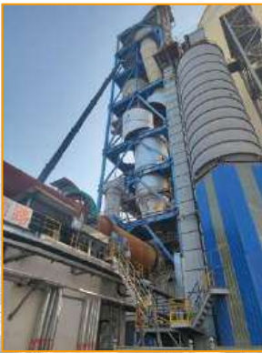
Lắp đặt mở rộng lò Calciner
