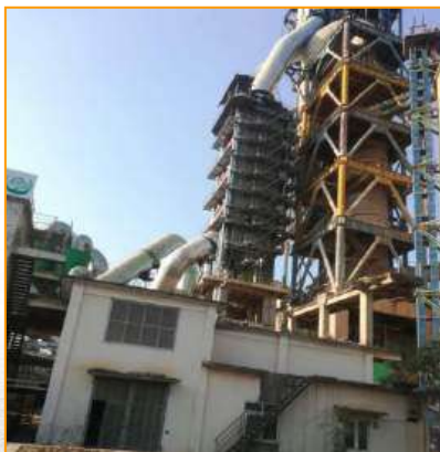
Dự án phát điện nhiệt dư đồng bộ NMXM Nam Sơn 3.300t/d 6MW
