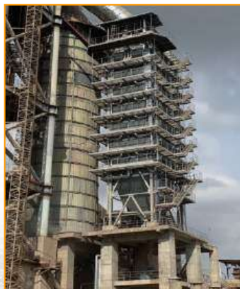
Dự án phát điện nhiệt dư đồng bộ NMXM Hướng Dương 2.500t/d 5MW
